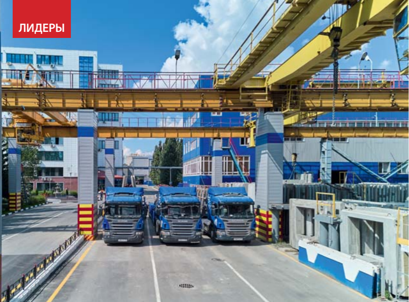
Погрузка готовой железобетонной продукции
